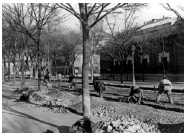
019.- Pamplona. Año 1910-1911. Imagen que recoge un momento del montaje de las vías en la calle Taconera.
