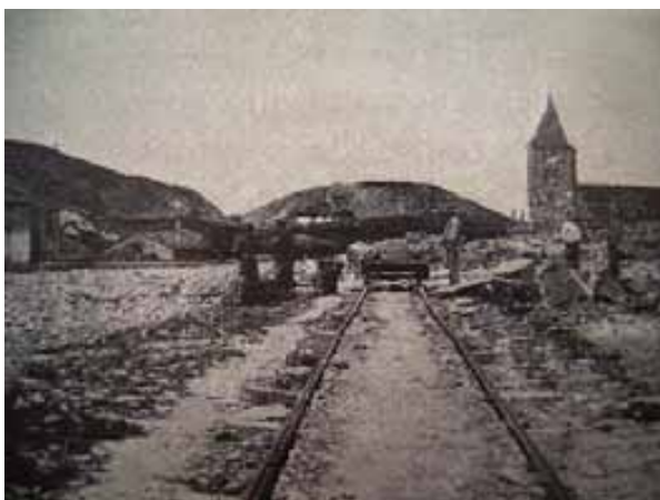
002.- Artajo (Valle de Lónguida). Trabajos de instalación de las vías del ferrocarril. (Cliché de Hermógenes Maiz. Foto publicada en el tomo II de la Geografía General del País Vasco-Navarro, de Julio Altadill).
