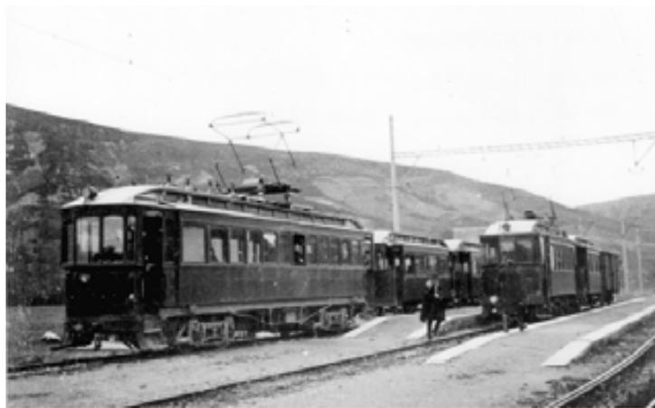
**068.-** Villaveta. Empalme de Aoiz. Vemos el tranvía en la vía de la derecha; en la otra vía, en dirección a Sangüesa, se ve un automotor grande.
